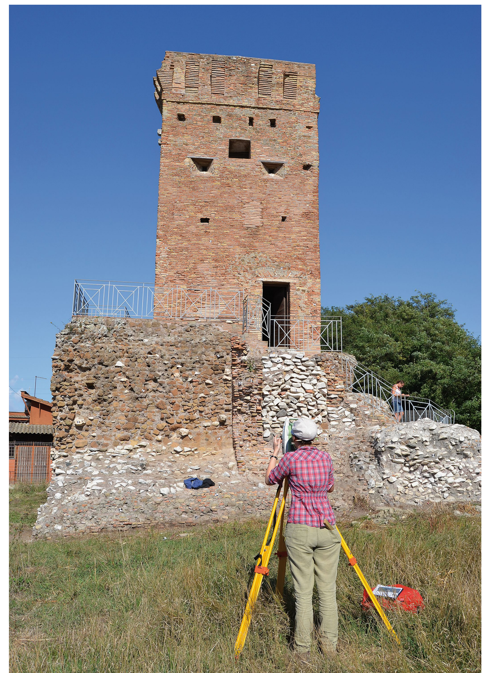
Arbeiten an der Westseite des „Tor Boacciana“
